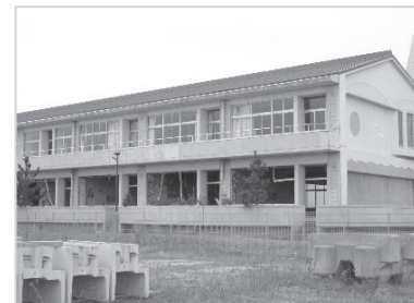
震災遺構 請戸小学校
