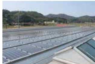
太陽光パネル(商品センター)
