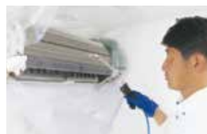
エアコンクリーニング
